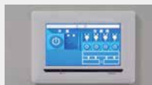
照明・空調制御
